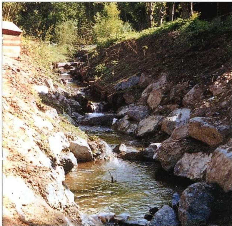
In der Metnitz bei Pöckstein befindet sich einer der bisher vierzehn in Kärnten errichteten Fischaufstiegshilfen. Weitere sollen nun folgen.
