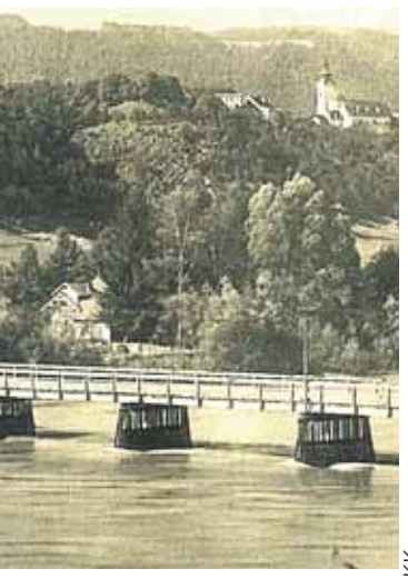
Detailansicht der „alten Drau“ vor dem Kraftwerksbau vor knapp vier Jahrzehnten.
